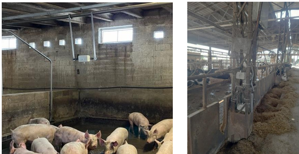
Figura 1 – Applicazione in porcaia (foto a sinistra) e stalla per bovine da latte (foto a destra) di una centralina multi-sensore per il monitoraggio in continuo della qualità dell'aria.
