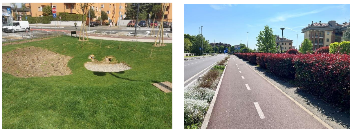
Figura 6 – Esempi di NBS per il drenaggio delle acque meteoriche in contesto urbano. Bacino (foto a sinistra) e aiuola (foto a destra) di ritenzione lungo via Matteotti a Bovisio Masciago (MB).
